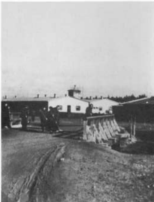
Kriegsgefangene beim Brückenbau
